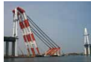
▲新湊大橋の主塔取付け工事(両方とも射水市教育委員会提供)
