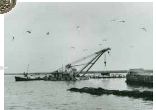
▲富山新港東防波堤の造成工事(昭和41年4月)
