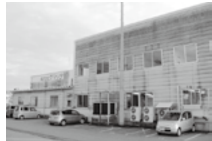
▲新湊工場(外観)
